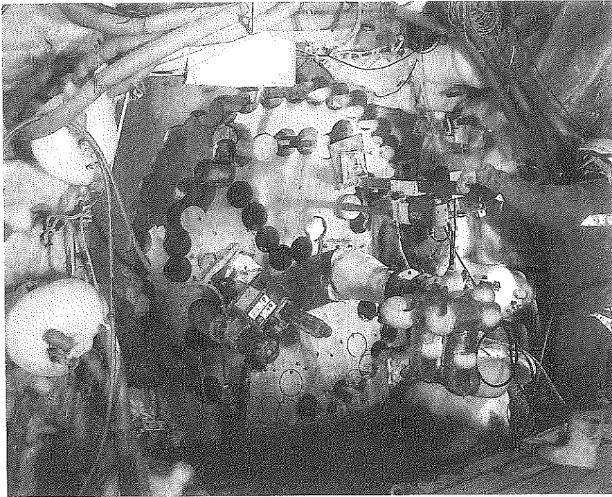
写真-9 二次覆工コア抜き状況
