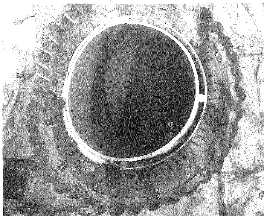
写真-14 FRPM管挿入完了
