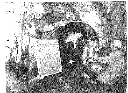
写真-11 鋼管圧入状況
