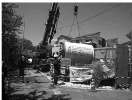
写真-8 掘進機搬入状況
