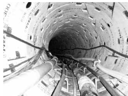
写真-16 R=10m管内状況
