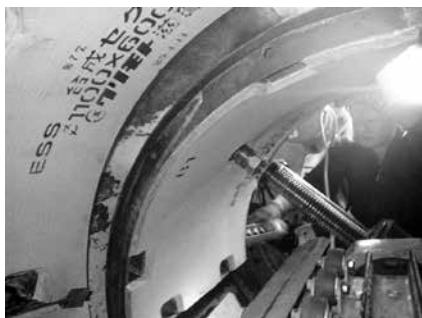
写真-14 セグメント組立状況
