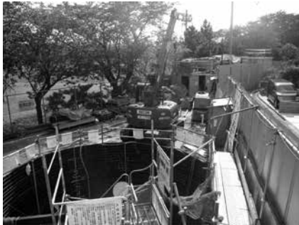
写真-4 発進基地状況
