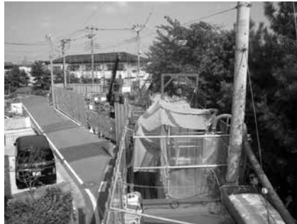
写真-5 発進基地状況
