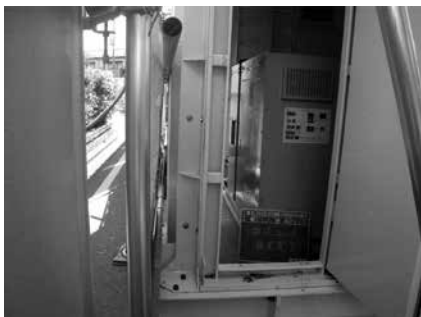
写真-6 防音ハウス
