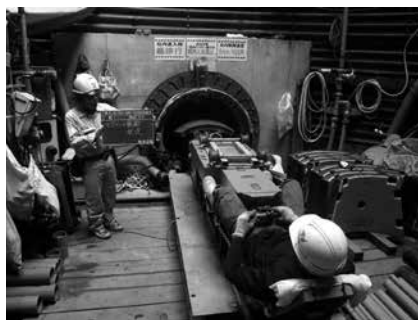
写真-12 セグメント搬入状況
