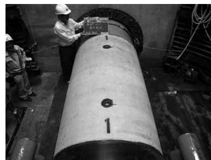
写真-10 推進管据付
